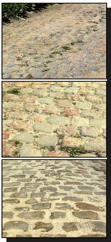
Fig. 3.41 Exemple de sols pavés.
