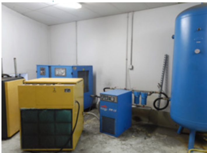
Compresseur d'air dans un local isolé des ateliers et insonorisé
