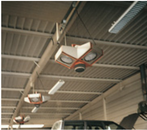
Réacteurs thermo-catalytiques étudiés pour le chauffage des locaux présentant un risque d'atmosphères inflammables ou explosives.
