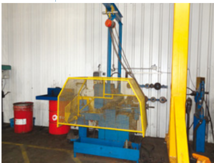
Tour utilisé pour la rectification des tambours : – un protecteur grillagé et basculant a été installé pour assurer la sécurité de l'opérateur, – un monorail avec palan facilite la mise en place des tambours sur la machine.
